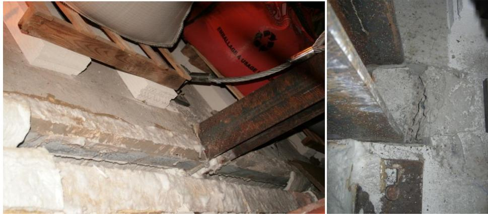
**Figura 7.42** Fendilhação do betão em torno dos pilares centrais
