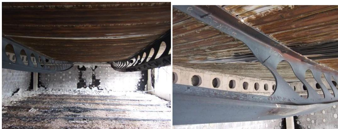
**Figura 7.53** Deformação da laje/viga não protegida após o incêndio.
