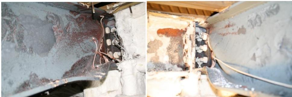
**Figura 7.39** Encurvadura local das vigas secundárias não protegidas ligadas ao pilar
