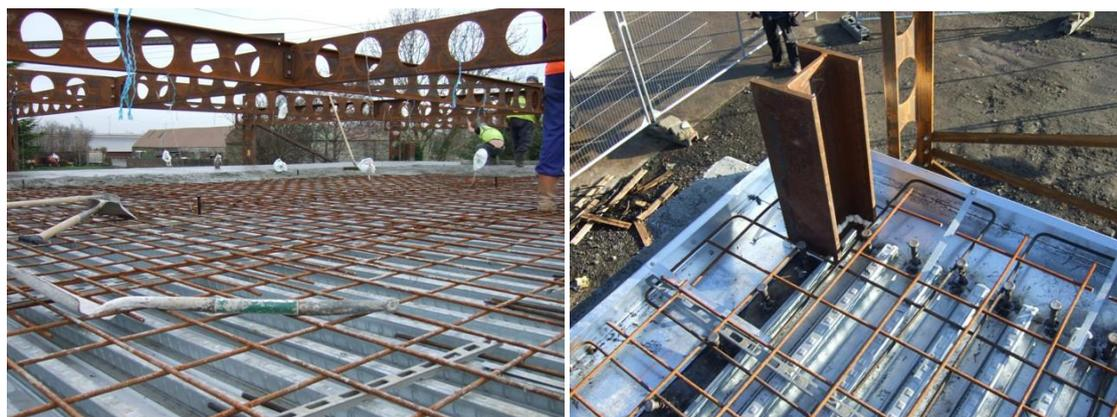
**Figura 7.48** Rede de armadura e pavimento metálico antes da betonagem
