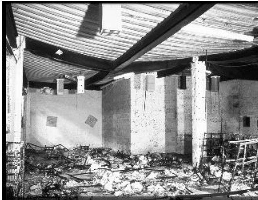
**Figura 2.19** Compartimento depois do incêndio
