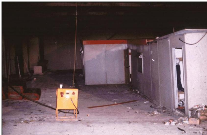
**Figura 4.2** Vista da deformação do pavimento acima do incêndio (a deformação máxima foi cerca de 600 mm)
