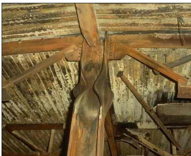
**Figura 4.1** Encurvadura de um pilar e deformada da viga na Broadgate
