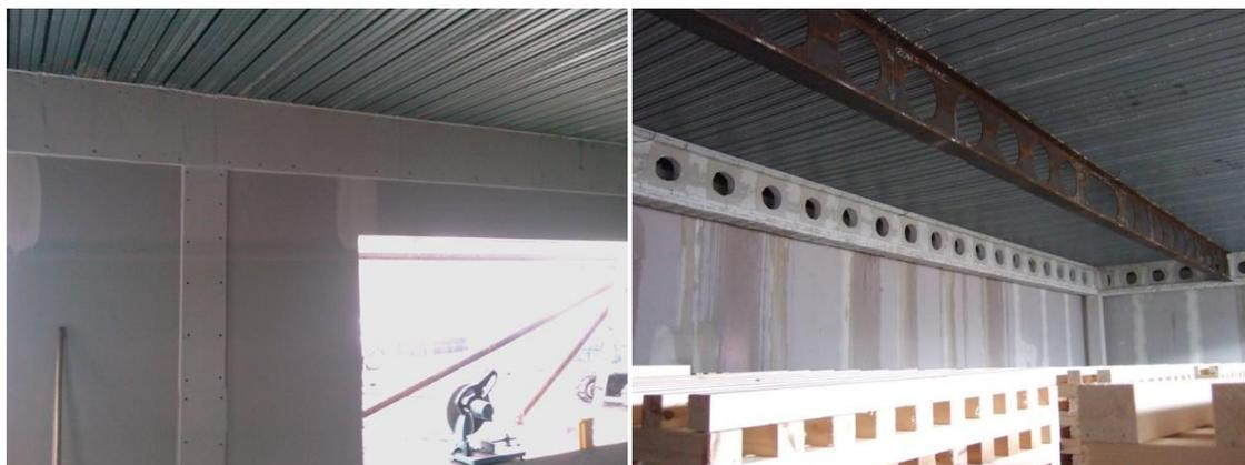
**Figura 7.47** Proteção de fibra e placa de gesso usada dentro do compartimento
