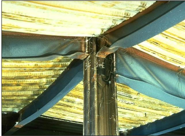
**Figura 2.20** Extremidade superior do pilar e encurvadura das vigas
