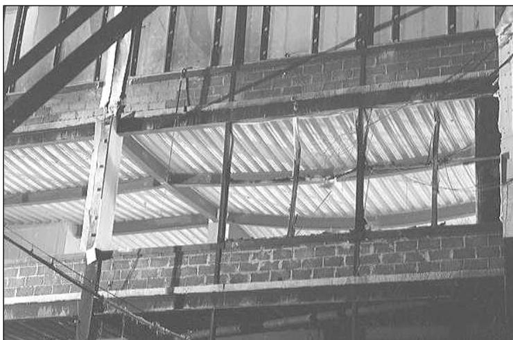
**Figura 2.14** Estrutura deformada durante o incêndio
