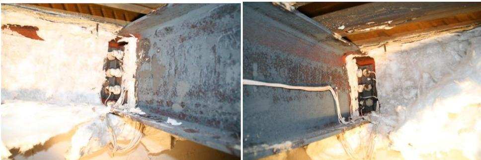
**Figura 7.40** Vigas secundárias não protegidas, sem encurvadura local, ligadas às vigas principais
