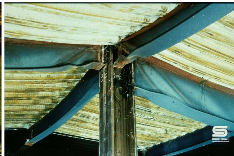
Estado de deformação dos elementos de aço em torno do pilar metálico protegido
