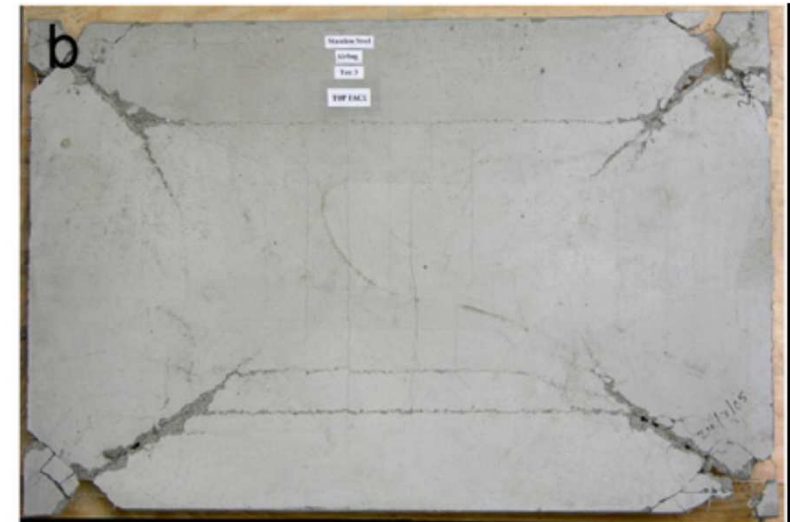
Rotura de compressão do betão
