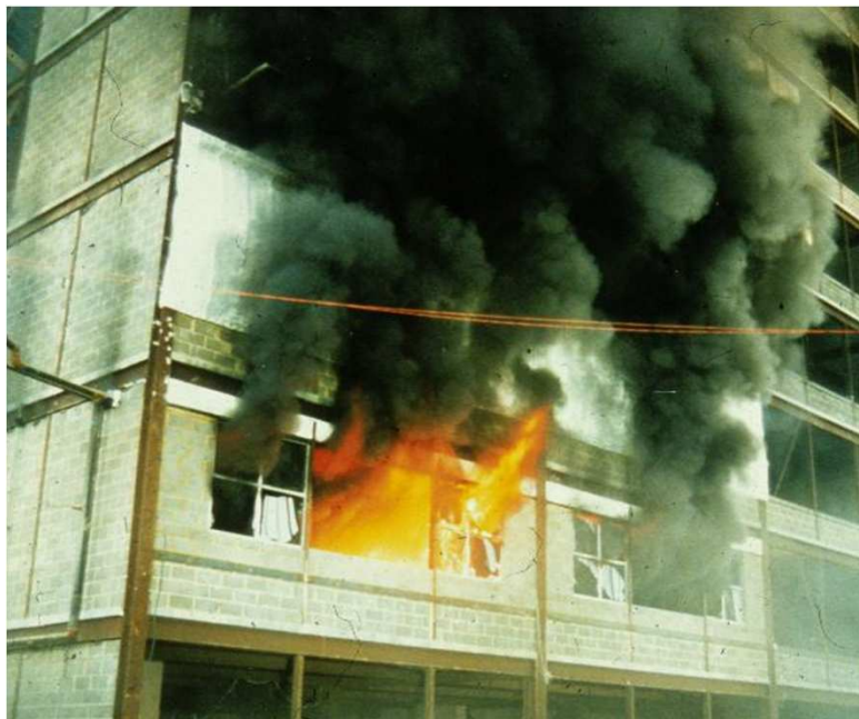
Estado inicial do incêndio
