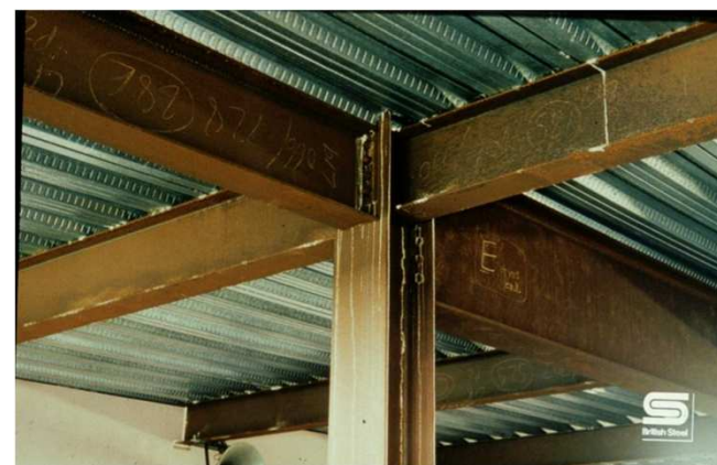
Ligação viga-pilar
