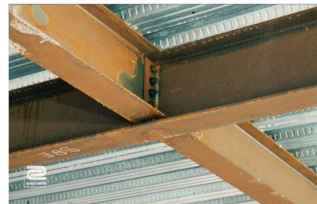
Ligação viga-viga
