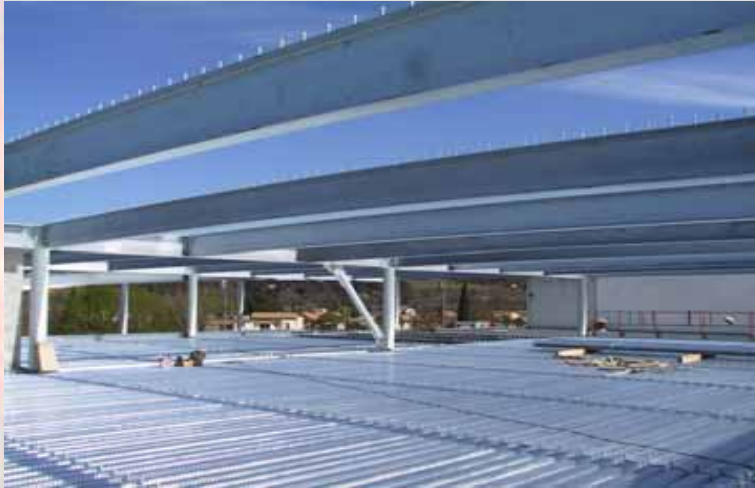
Durante a construção
