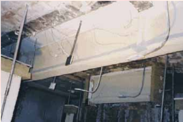
Viga antes do ensaio ao fogo
